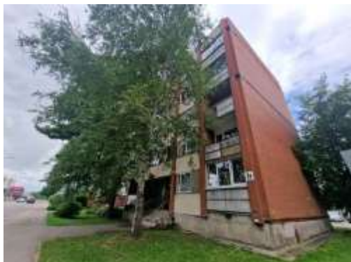
Dzīvojamā māja Balvu ielā 3A
